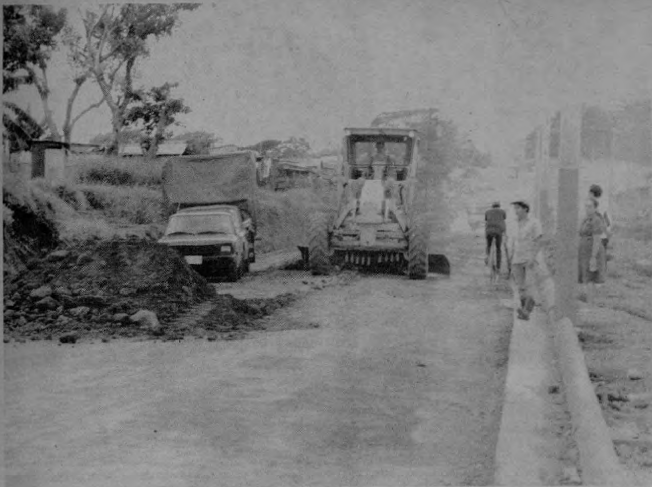
La presión de la comunidad obligó a la municipalidad de San José a iniciar la reparación de la vía que conduce a Lomas del Río de Pavas.
